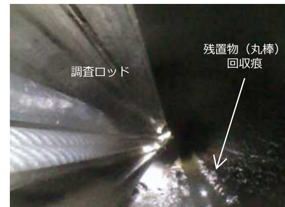
残置物（丸棒）撤去後のX-53ペネ内状況
