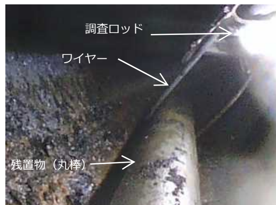
残置物（丸棒）の撤去時の状況
