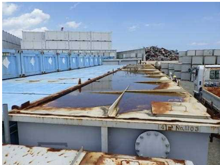
ノッチタンク上部の状況 (2021.7.6撮影)
