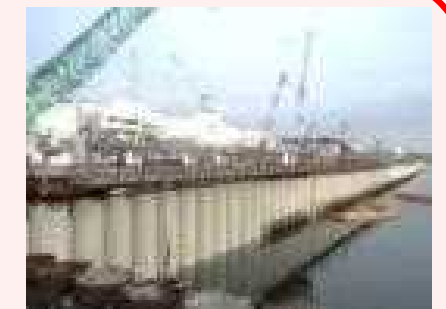
海側遮水壁 鋼管矢板打設完了状況
