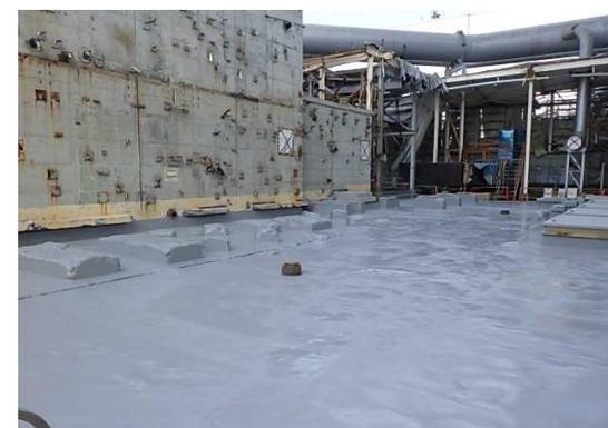
写真D 2号機Rw/B (ガレキ撤去・防水後)
