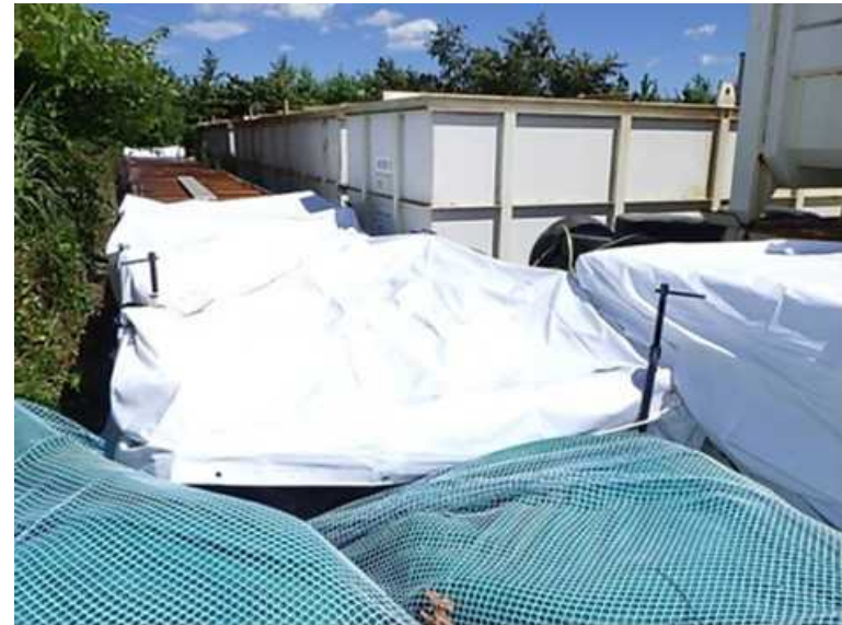
シート養生後
