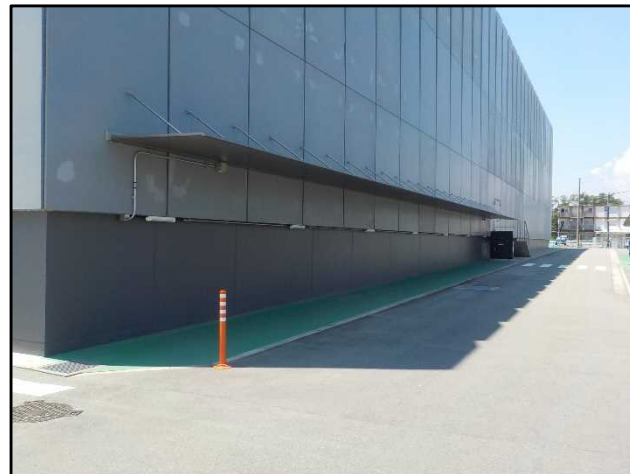
【歩廊（安全通路）②】
