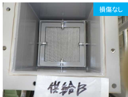
既設ALPS 供給タンクB
