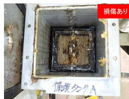
既設ALPS 循環タンクA
