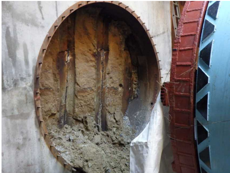
写真① 鏡切り完了状況（両発進立坑） （9月7日撮影）
