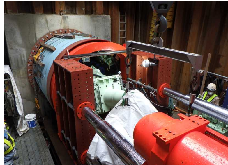
写真② 推進機初期掘進状況（両発進立坑） （9月16日撮影）
