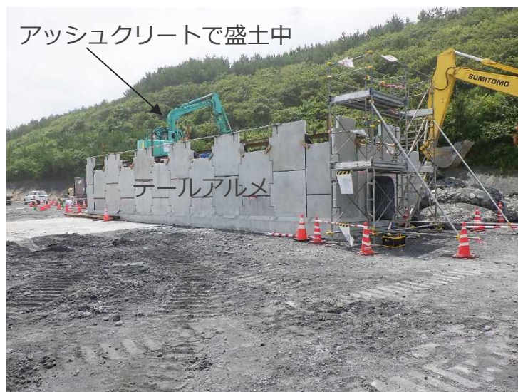
試験施工状況（2021年8月2日撮影）
