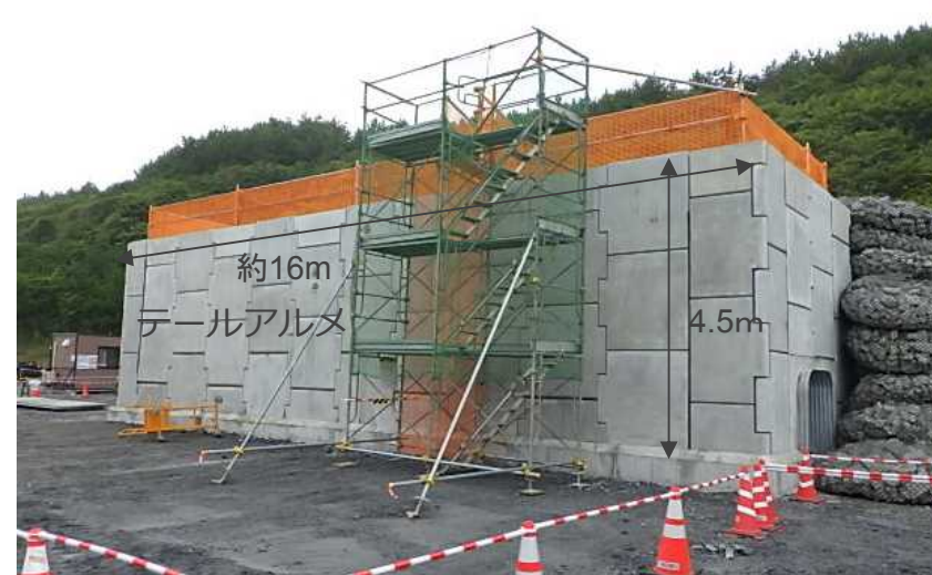
試験施工状況（2021年9月8日撮影）
