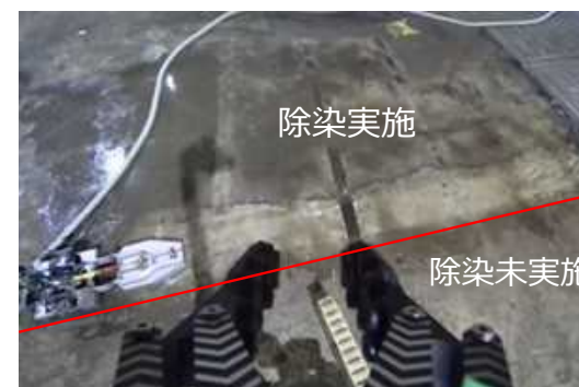
②床面の高圧水除染状況
