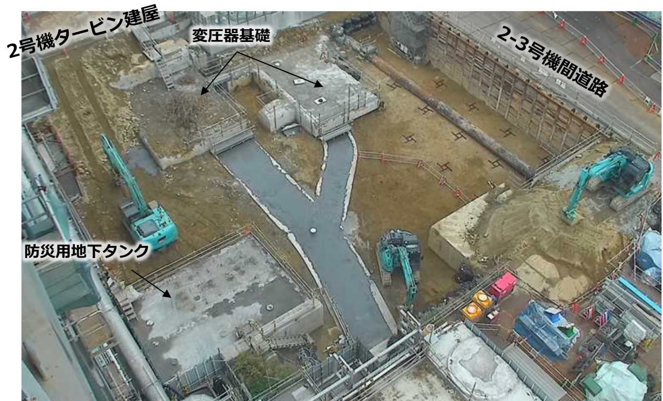
2号機原子炉建屋南側ヤード状況（撮影日：2021年9月16日）
