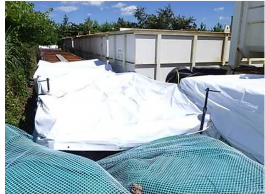
シート養生後
