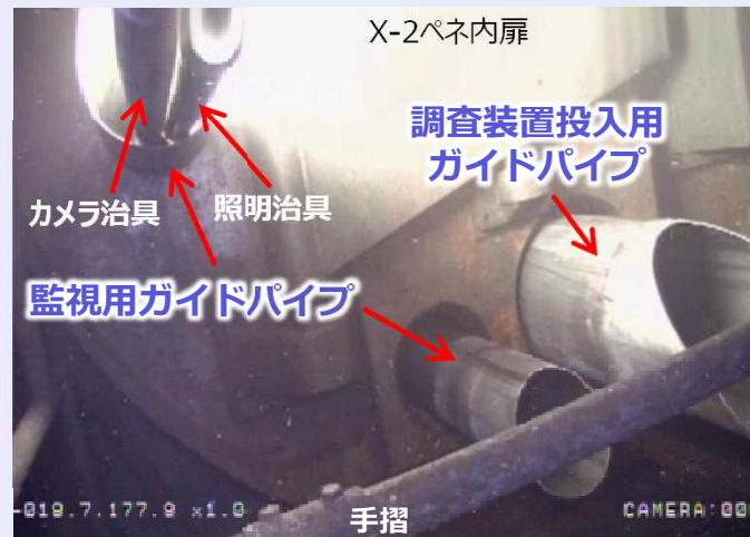
<ガイドパイプ設置状況>
