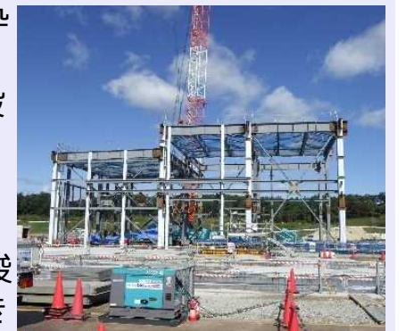
<建設状況（2021年10月20日撮影）>
