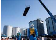
溶接タンク建設中の様子
