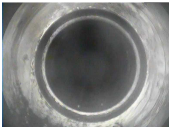
ペネ孔径拡大後 (孔径φ130)
