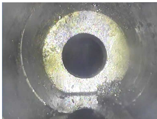
ペネ孔径拡大前 (孔径φ50)
