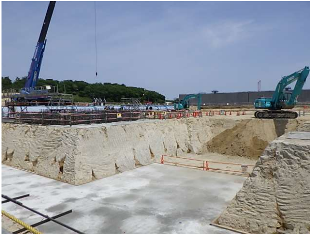
地盤改良・掘削 (2021/5/14撮影)
