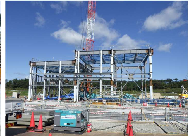
鉄骨工事 (2021/10/20撮影)
