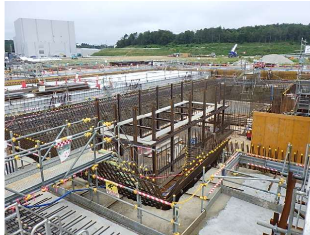
基礎工事 (2021/8/20撮影)
