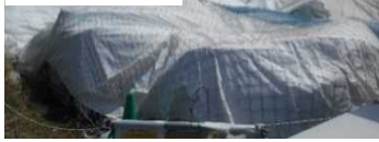
シート養生 (0.1~1mSv/h)
