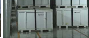
固体廃棄物貯蔵庫
