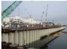
海側遮水壁打設完了の様子
