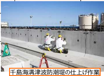
日本海溝津波防潮堤建設中の様子
