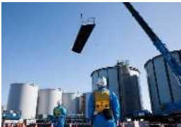
溶接タンク建設中の様子
