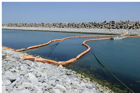
（既設）5・6号機取水路開渠シルトフェンス展開状況
