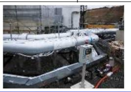
陸側遮水壁ブライン（冷媒）循環配管
