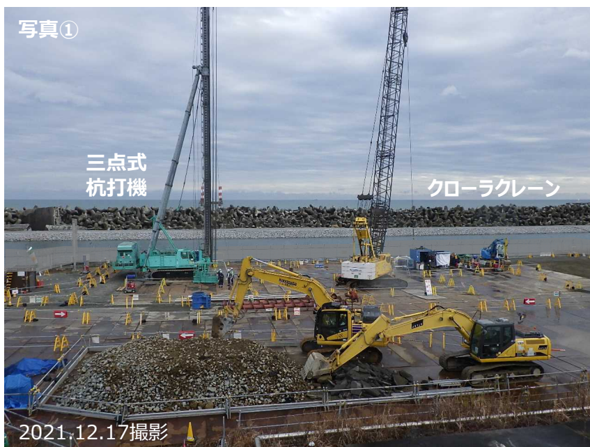
5・6号機取水口付近ヤード全景
