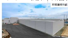
固体廃棄物貯蔵庫第9棟外観
