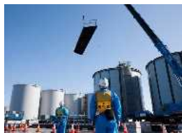
溶接タンク建設中の様子
