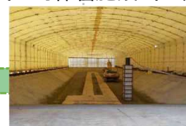
覆土式一時保管施設第3槽全景
