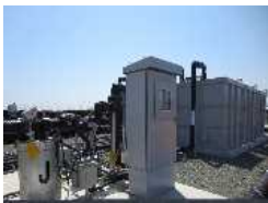
地下水バイパス揚水井
