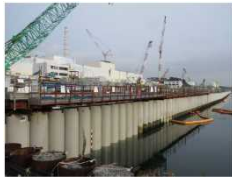
海側遮水壁打設完了の様子
