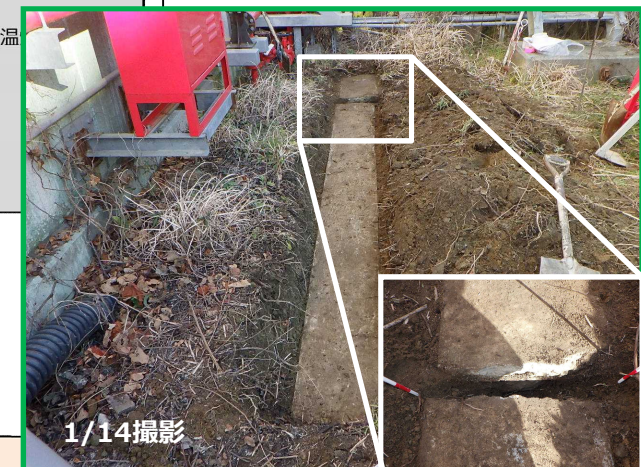
雨水排水設備（地下側溝）の損傷箇所
