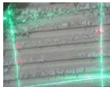
③天井面除染前
