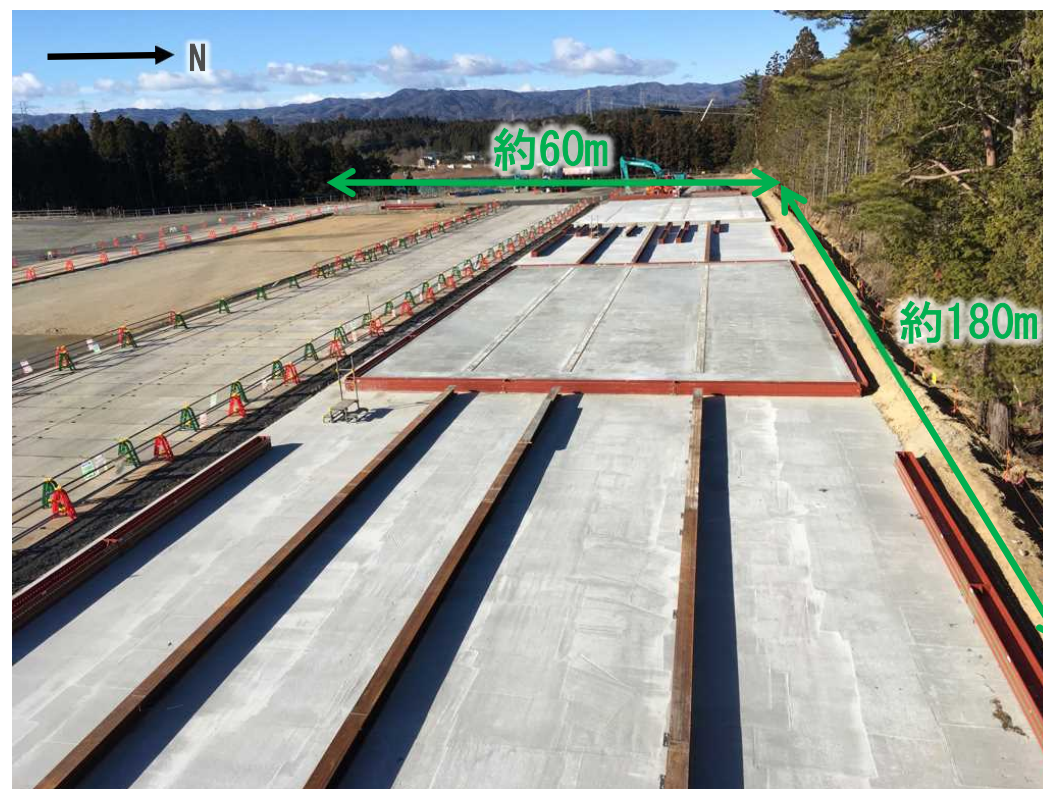
構外ヤード全景（撮影：2022.1.19）
