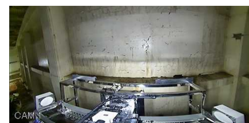
高所壁面除染後
