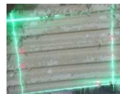
天井面除染後
