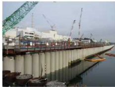
海側遮水壁打設完了の様子
