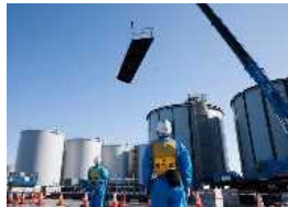
溶接タンク建設中の様子
