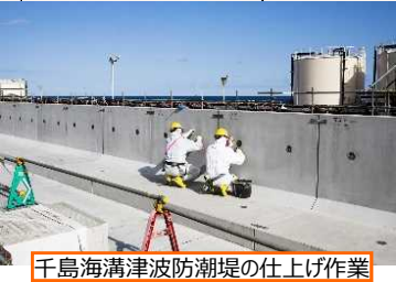
千島海溝津波防潮堤の仕上げ作業
