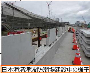
日本海溝津波防潮堤建設中の様子
