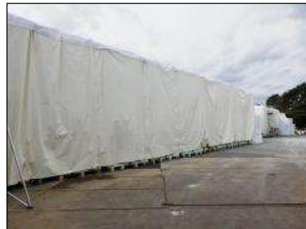
仮設シート養生については、より耐候性の高い本設シート養生へのリプレースを実施中
