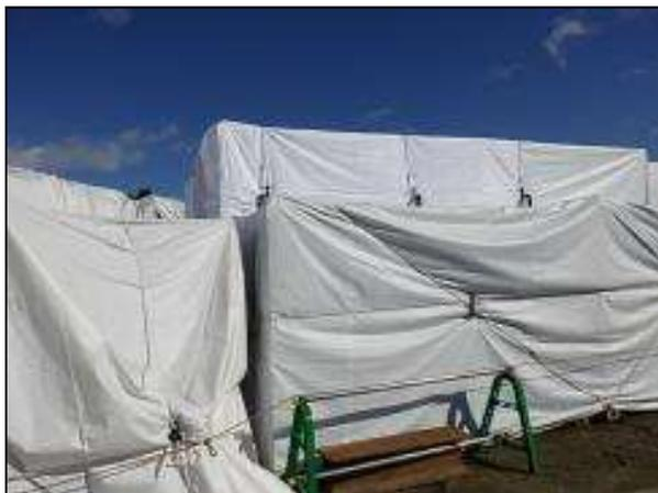
雨水の侵入を早期に抑制止するため、仮設シート養生を実施
