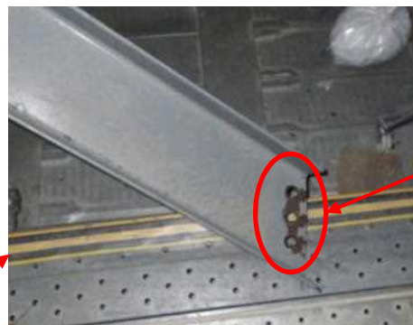
接合部のボルトが破断
