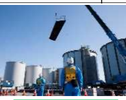
陸側遮水壁ブライン（冷媒）循環配管
