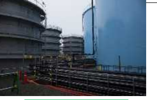
海側遮水壁打設完了の様子
