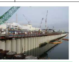
溶接タンク建設中の様子
