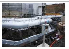
サブドレン浄化設備
