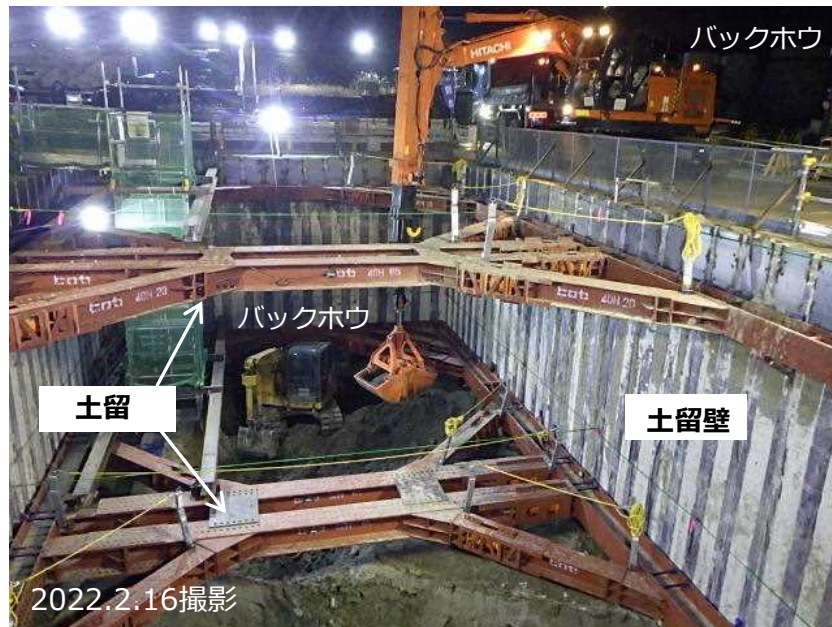
写真① 立坑掘削状況
