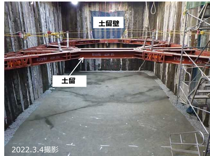
写真② 立坑掘削完了
