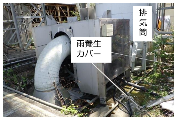
排気筒サンプ周辺状況
