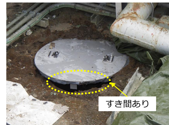
サンプ南東部のマンホール
