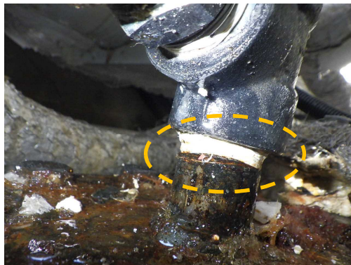
凍結管継手部 漏えい箇所
