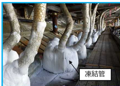
エリア④ ・ヘッダー管は架台上部に配置 ・ヘッダー管/凍結管距離：400～500cm
