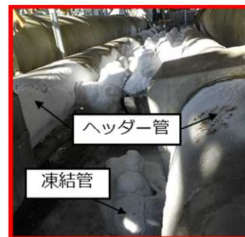
エリア① ・ヘッダー管の間に凍結管が配置 ・ヘッダー管/凍結管距離：30～50cm ※ 着氷時には接する箇所あり
