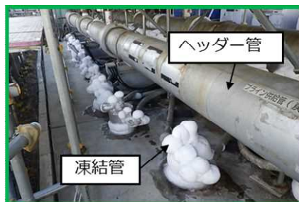
エリア③ ・ヘッダー管の外側に凍結管が配置 ・ヘッダー管/凍結管距離：100cm程度
