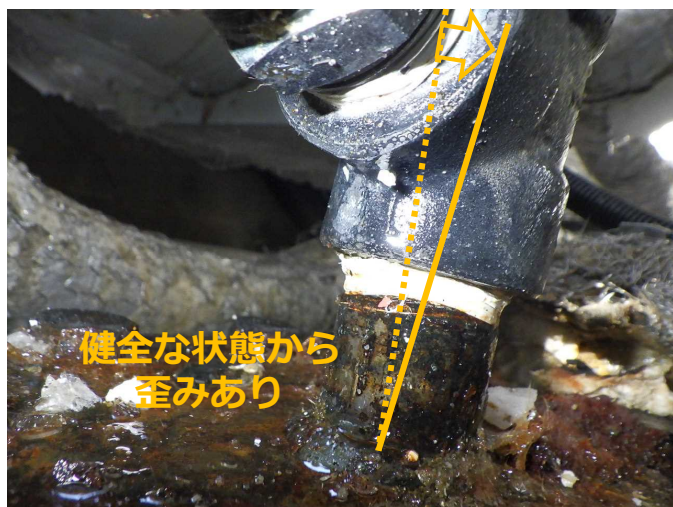
【50-5T 凍結管継手部歪みの目視確認】
