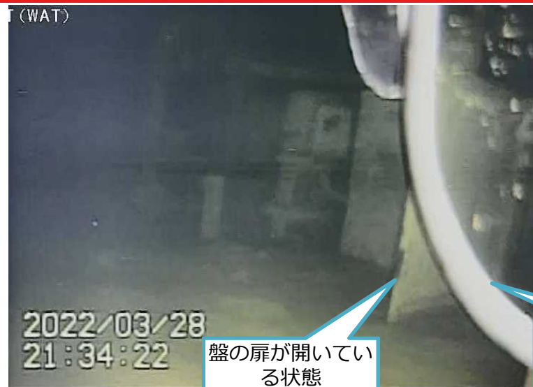
写真1.ペDESTAL外壁に設置されている盤※
