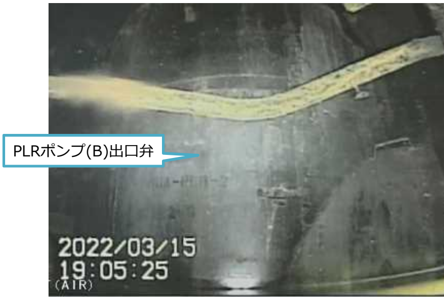
写真1. PLRポンプ(B)出口弁付近の状況
