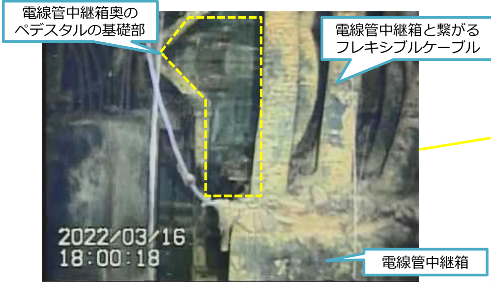
写真1.ペDESTAL基礎部付近の状況①
