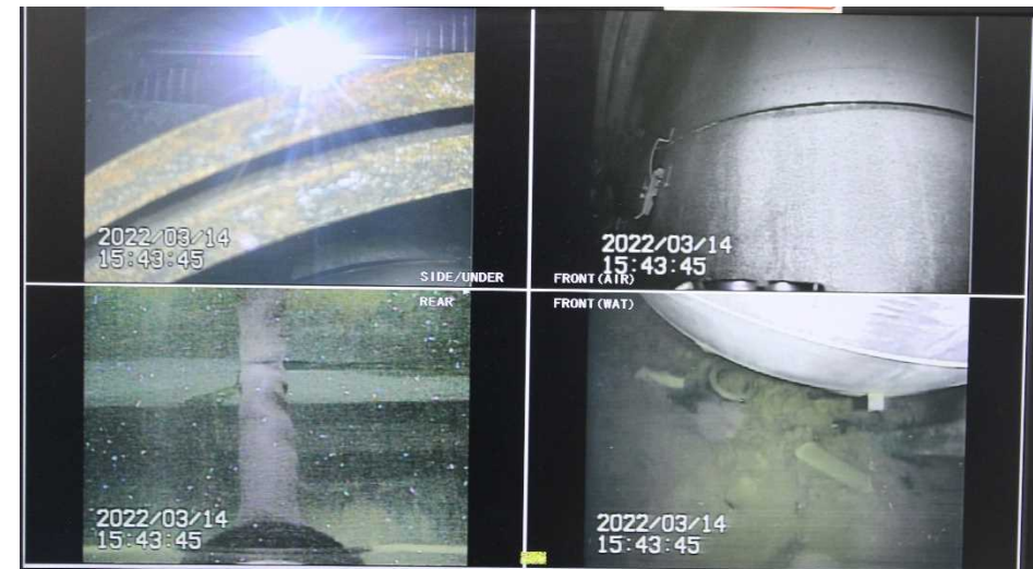
写真4.吊り下ろし地点での状況
