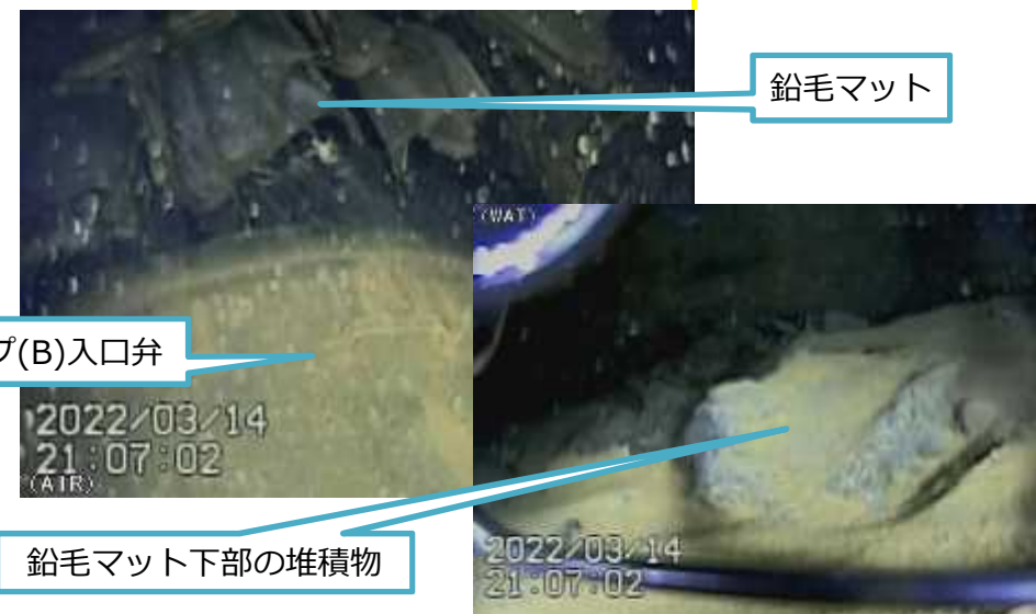
写真3. PLRポンプ(B)入口弁付近の状況
