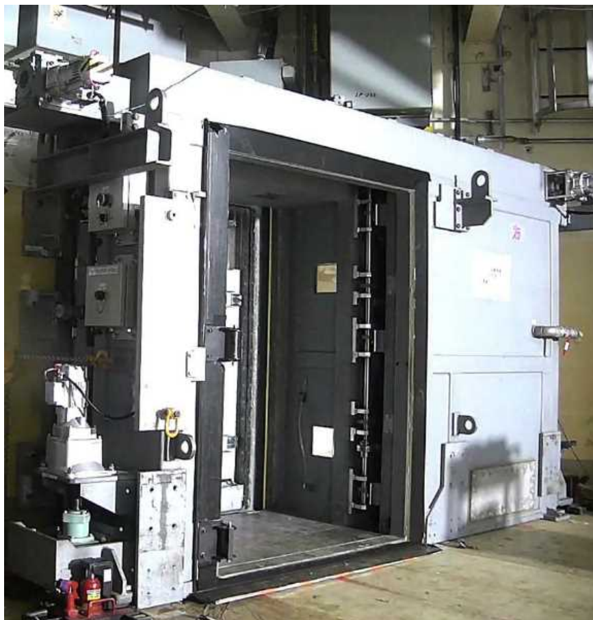
隔離部屋②の設置状況
