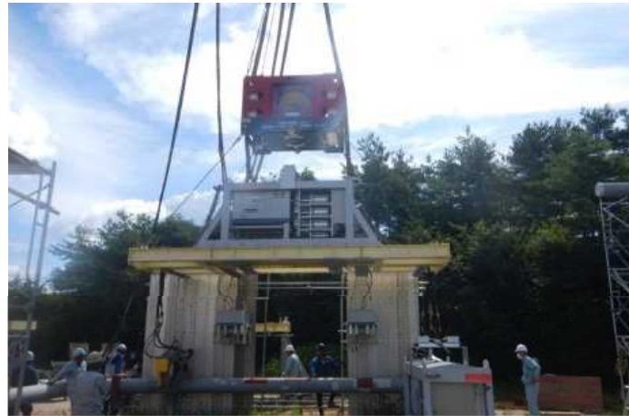
装置一式 (吊り天秤、切断装置等)
