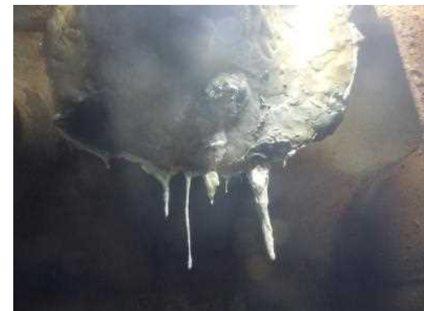
止水により地下水流入停止
