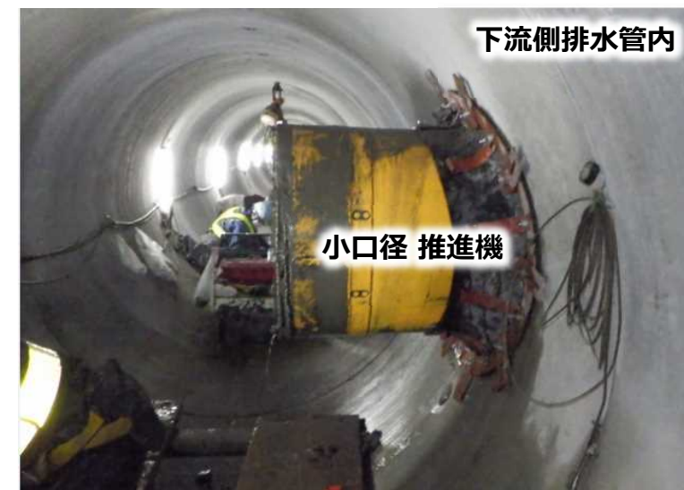
写真⑤ 小口径_本管接続
