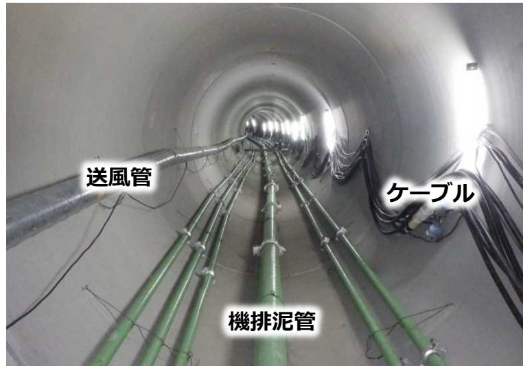
写真② 上流側推進管内部
