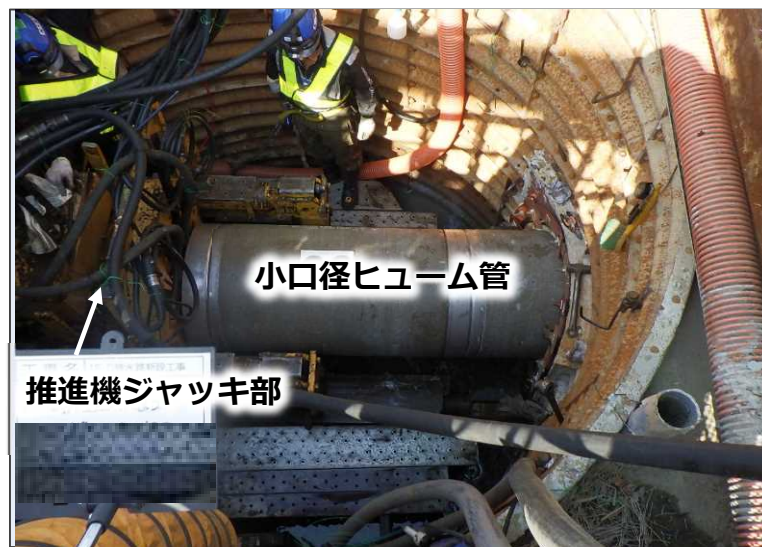
写真④ 小口径_接続桝B
