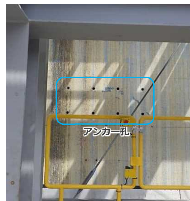
アンカー孔の削孔状況 （撮影：2022年4月13日）
