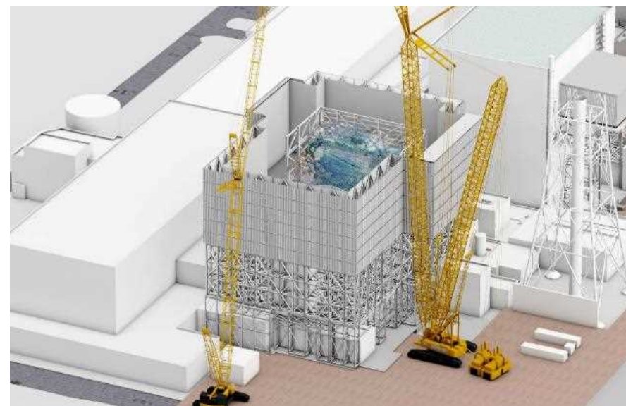
上部架構設置完了
