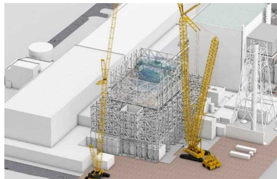
下部架構設置完了
