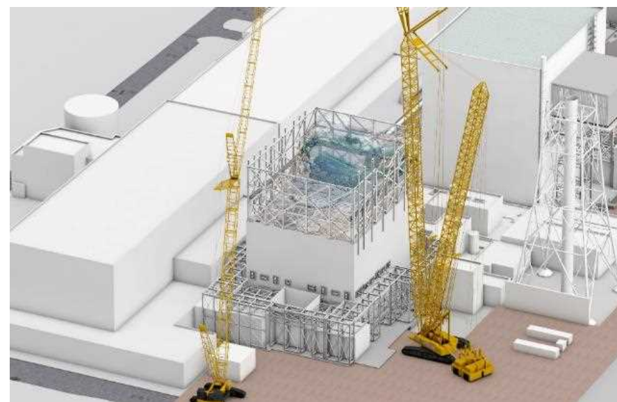
仮設構台設置完了
