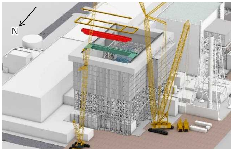
ガレキ撤去用天井クレーン設置中
