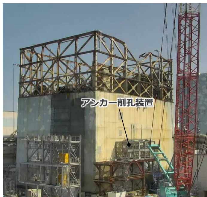
現場状況（北西より） （撮影：2022年4月12日）
