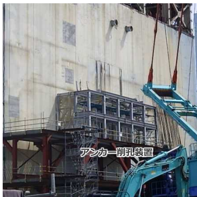
アンカー削孔装置 （撮影：2022年4月13日）
