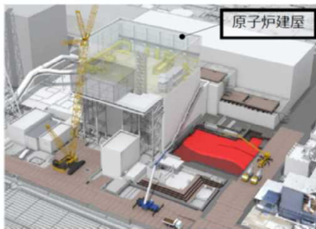
①基礎CON打設
