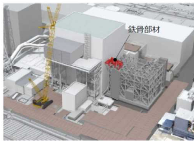
⑤構台鉄骨建方(3層目開始)
