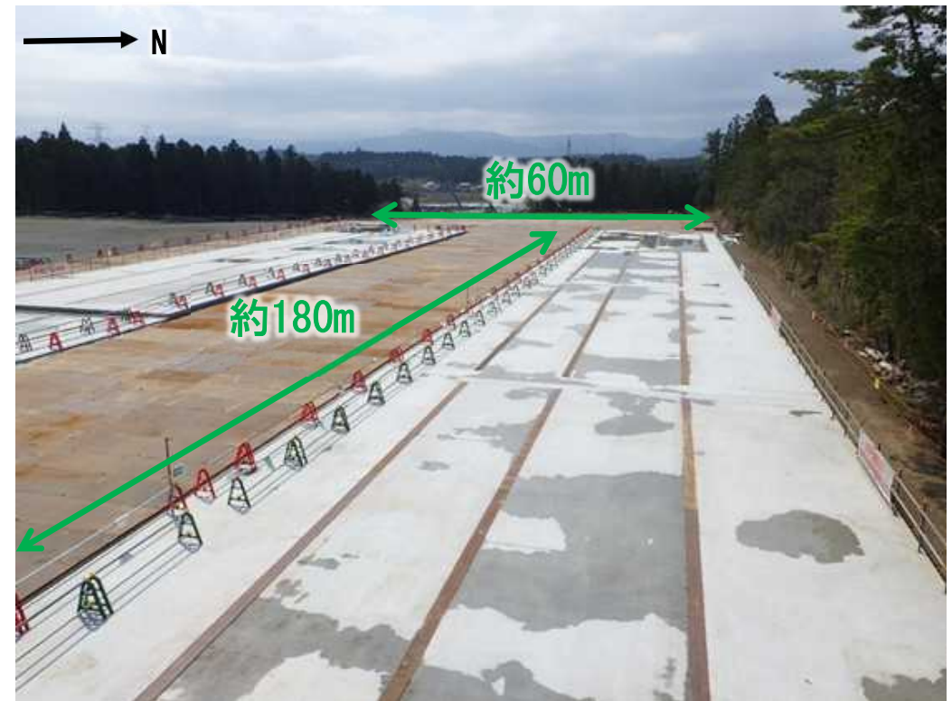
構外地組ヤード全景（撮影：2022.4.20）
