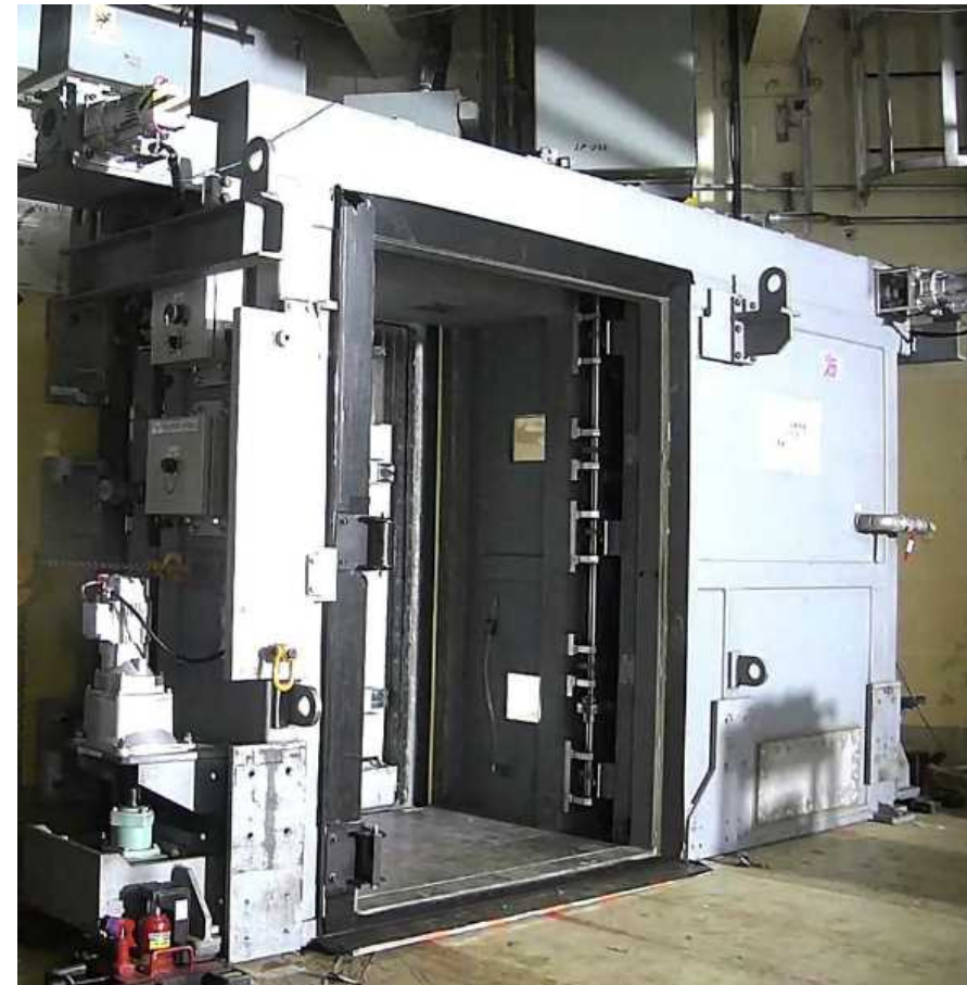
隔離部屋②の設置状況
