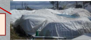
瓦礫 (シート養生)
