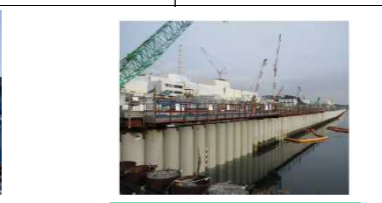
海側遮水壁打設完了の様子
