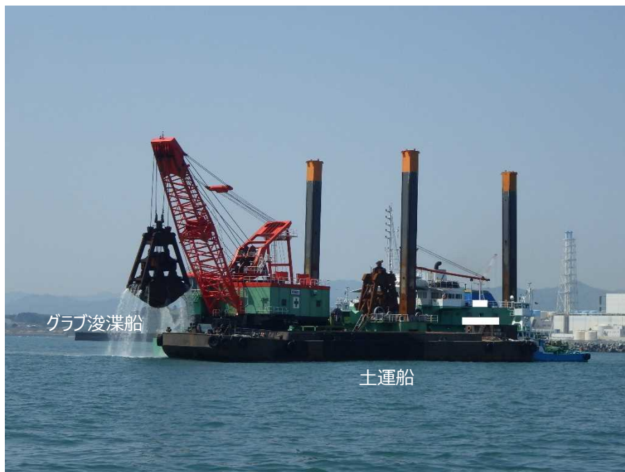
海上掘削作業（沖合）
