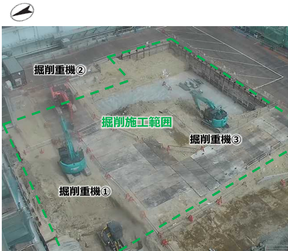
2号機原子炉建屋南側ヤード状況（撮影：2022年5月12日）
