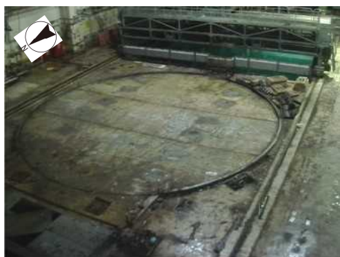
遮蔽設置前の状況
