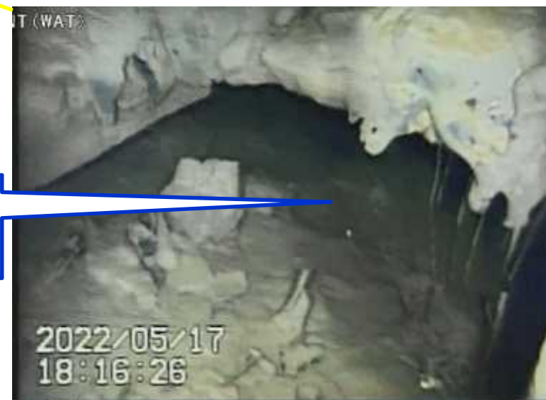
写真3.PCV底部の堆積物の状況(空洞内部)
