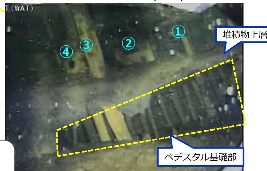
写真2.ペDESTアル基礎部(下部)の状況
