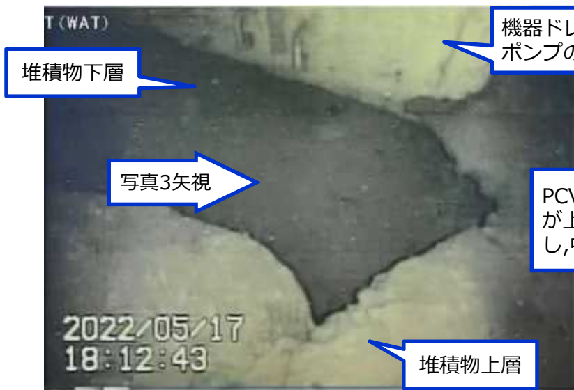
写真2.PCV底部の堆積物の状況
