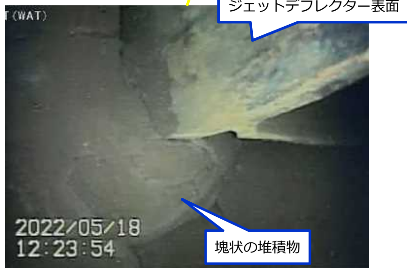
写真2.ジェットデフレクター(E)表側下部の状況
