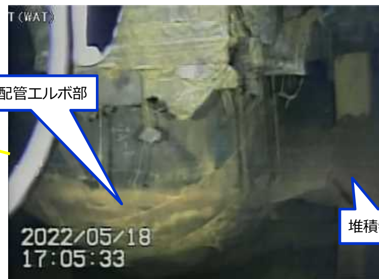
写真1.PLR(A)配管の状況
