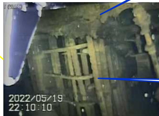
写真3.ペDESTAL開口部(右側基礎部)の堆積物より下部の状況
