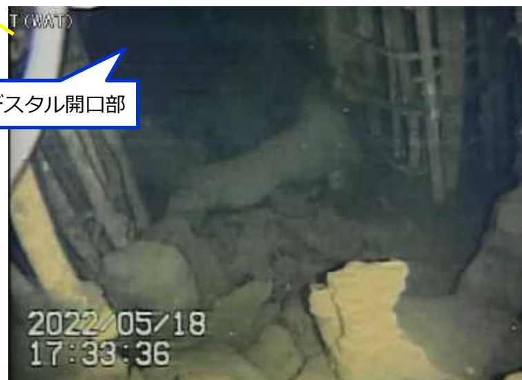
写真3.ペDESTAL開口部前の堆積物の状況
