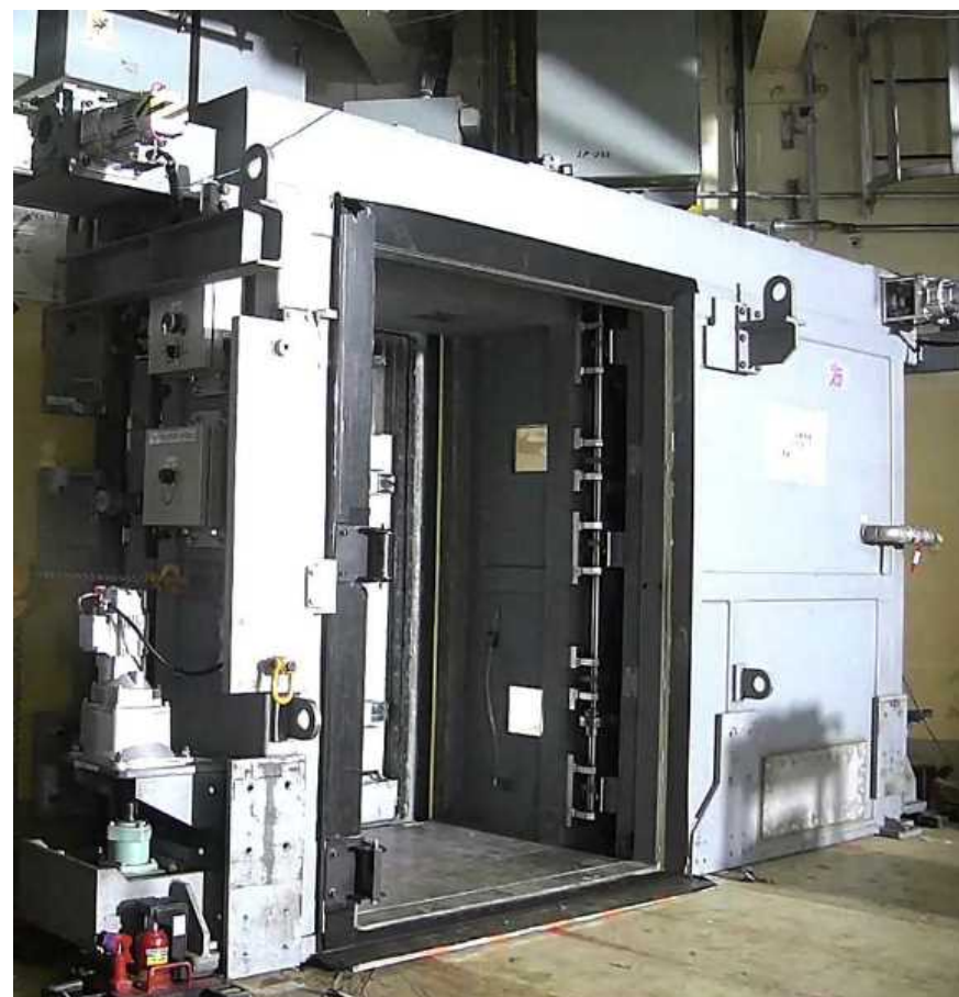
隔離部屋②の設置状況
