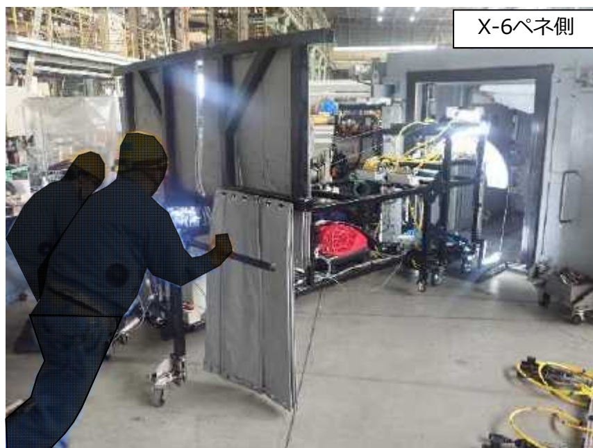
シール機構取付け装置 写真：モックアップ時
