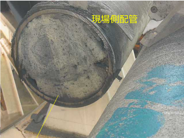
下流側（排気筒側）
