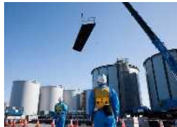
溶接タンク建設中の様子
