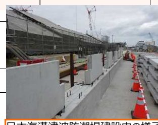
日本海溝津波防潮堤建設中の様子
