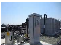
地下水バイパス揚水井
