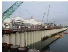
海側遮水壁打設完了の様子
