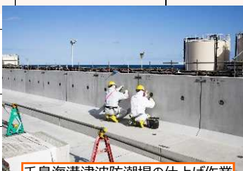
千島海溝津波防潮堤の仕上げ作業
