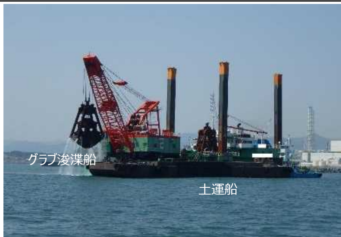
海底掘削作業（沖合）
