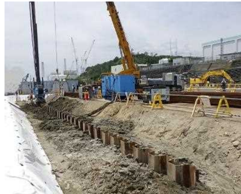
土留め工の状況
