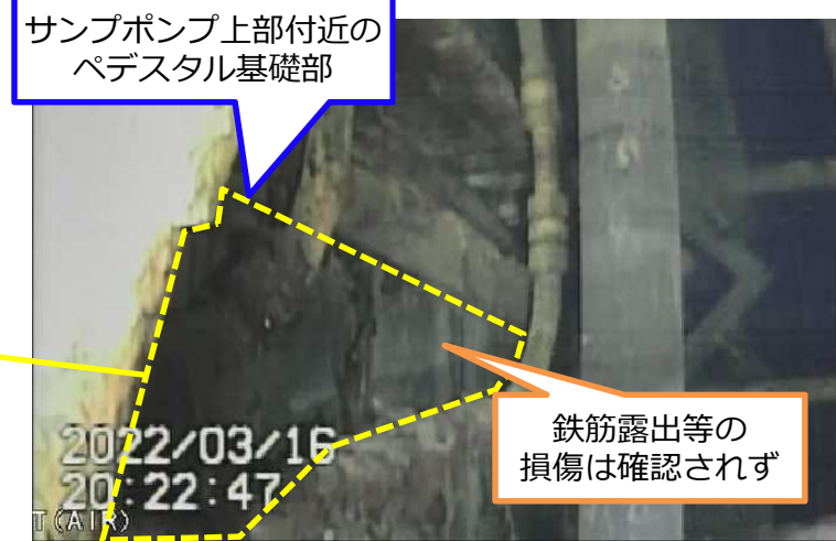
写真5. 遮へい板裏ペデスタル壁面(堆積物上部)
