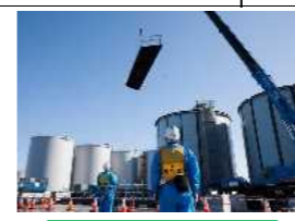
サブドレン浄化設備
