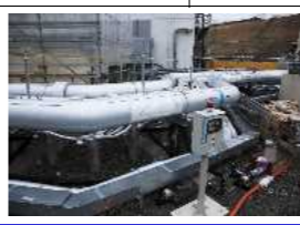
地下水バイパス揚水井
