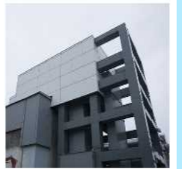
<4号機 燃料取り出し用カバー>
