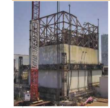
<1号機 残置カバー解体中の様子>
