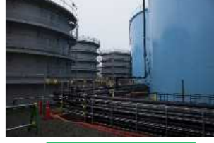
溶接タンク建設中の様子
