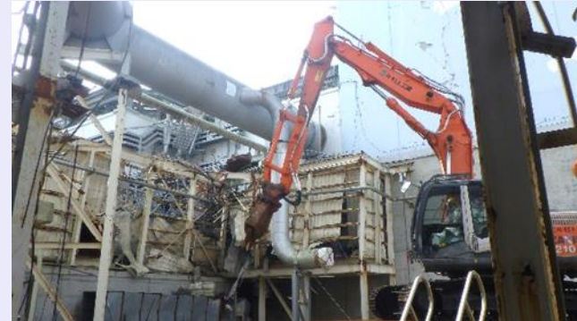
＜ガレキ撤去作業の様子＞
